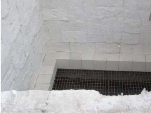
LanteComb<sup>®</sup> 이 다른 매체를 사용하여 당초에 설계되었던 RTO들의 성능의 제고를 위하여 설치될 때, 지지판이 어떤 문제들을 제기 시킬 지도 모릅니다. 무작위 충전 매체들을 사용했던 RTO내에 통상 설치되는 다공형 금속제 판들은 쓸데없이 압손을 증가시킵니다. 만약, LanteComb<sup>®</sup>을 이런 다공성 지지대 위에 교체 설치하면 매체에서는 개방된 유로 면들이 금속제 지지대로 인해 막혀서 압손이 크게 발생하고 열 회수의 일부 감손을 초래할 것입니다.
