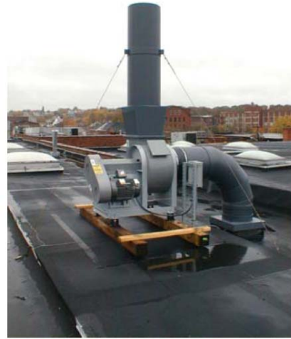
그림 2 - 지붕에 설치된 배기 송풍기
