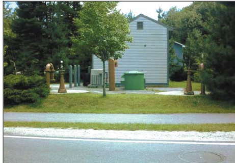
뒷 마당에 이웃집을 가진 Windy Point 양수 펌프장
