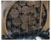
그 플라스틱제 Q-PAC<sup>®</sup> 미생물 서식처는 새 것일 때 30ft²/ft³의 원형 표면을 가집니다. 그 Q-PAC<sup>®</sup> 위에 미생물 막이 쌓임에 따라 폐수와 접촉하는 미생물 막의 원형 표면들은 그 미생물 막의 두께와 함께 기하학적으로 증가합니다. 이 증가된 표면은 Q-PAC<sup>®</sup>의 유효 표면적을 60 그리고, 90ft²/ft³까지 확대합니다. 미생물 막의 질량이 증가함에 따라, 미생물 반응조 내의 층류 유동과 공기 주입 시스템에 의하여 형성되는 방울들의 활동에 도움들 받아, 미생물 막은 종국에는 Q-PAC<sup>®</sup>의 침상 봉들로부터 떨어져 나갑니다.
