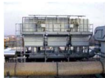
그림 2 현대적인 3 Canister형 RTO
