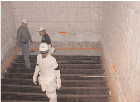
볼들과 MLM<sup>®</sup>의 적합한 설치 위치를 가리키는 벽의 표시에 따라 25-mm 세라믹제 볼들이 설치되었습니다.
